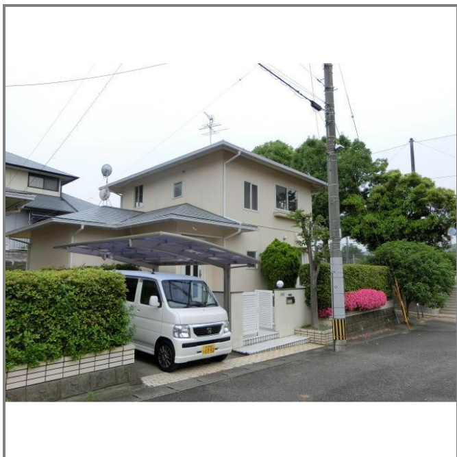
平成22年1月外壁の塗装
